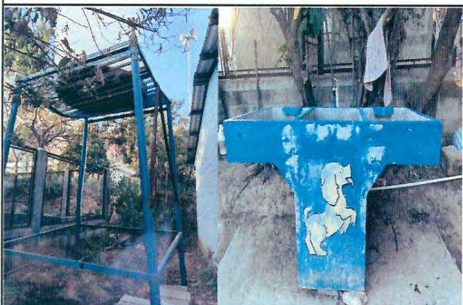
Foto 3: reparación o sustitución de pila y deposito de agua
