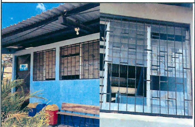
Foto 4: reparacion y sustitución de percianas de aulas
